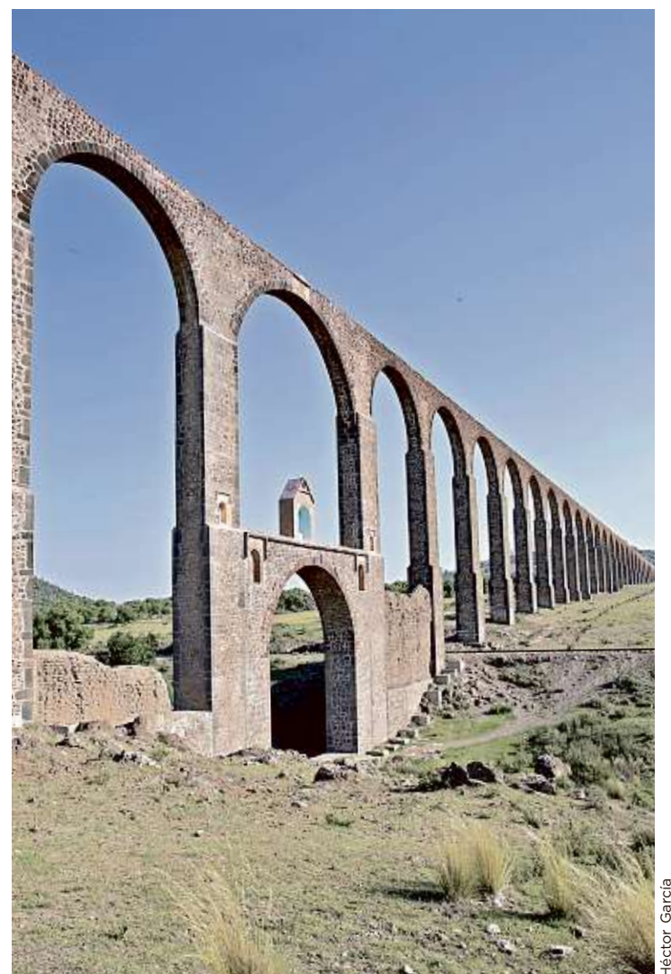
■ El Acueducto del Padre Tembleque es la obra de ingeniería hidráulica más importante del Virreinato.
